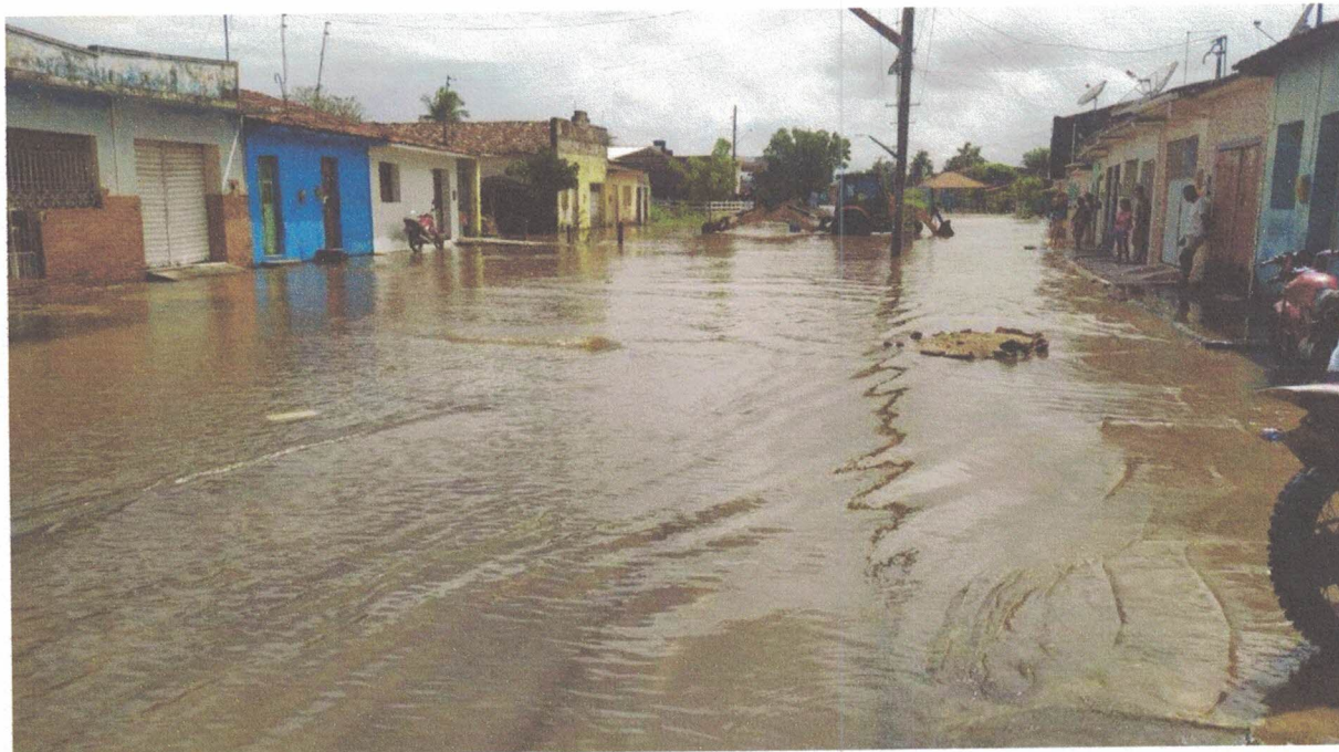
Imagem 7: Rua Neto Bonfim Alagada
