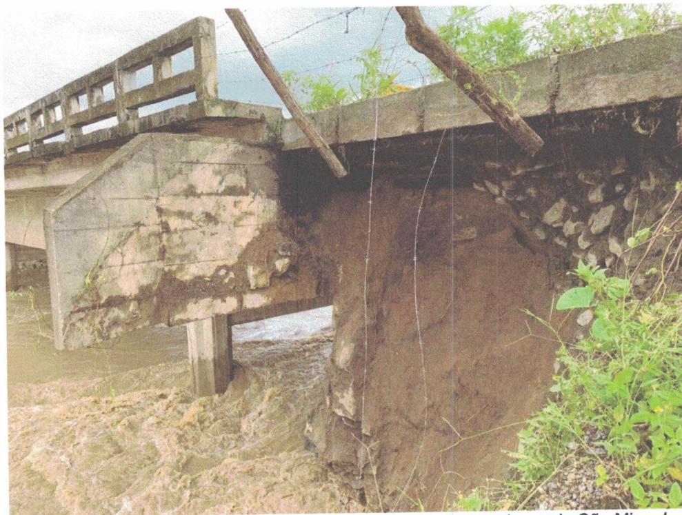
Imagem 10: Vista inferior de uma das cabeceiras da ponte sobre o rio São Miguel, no povoado Tapera, AL-450
